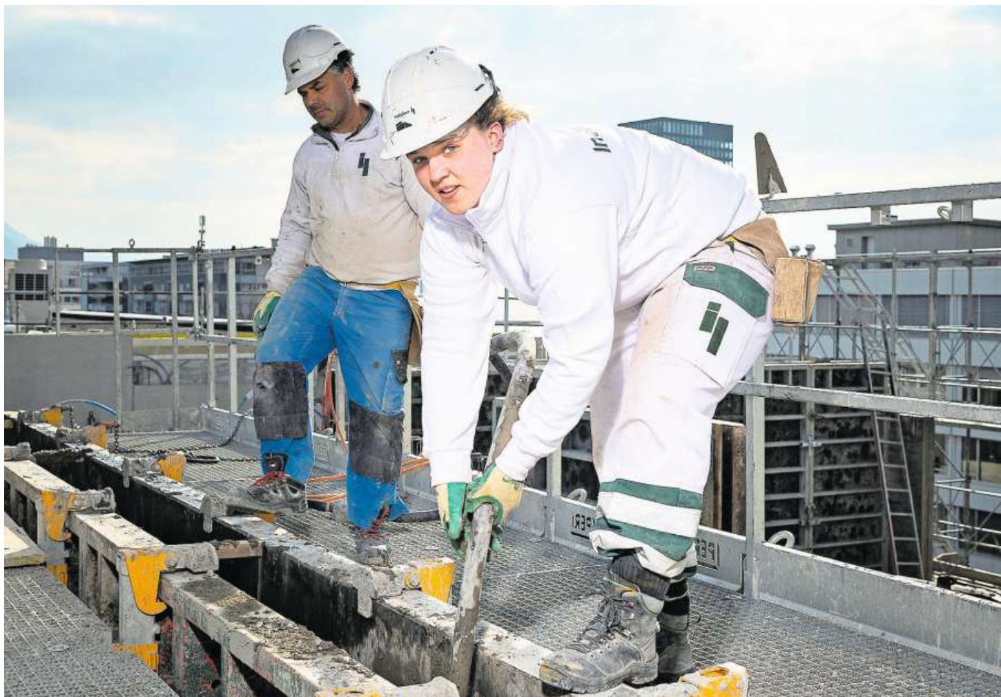
Die junge Handwerkerin Alischa Fähndrich fühlt sich wohl auf der Baustelle.
